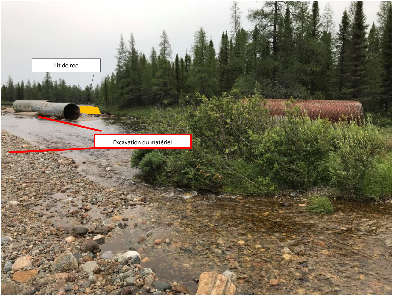
Figure 5. Zone d'excavation du matériel (vue depuis l'aval).
