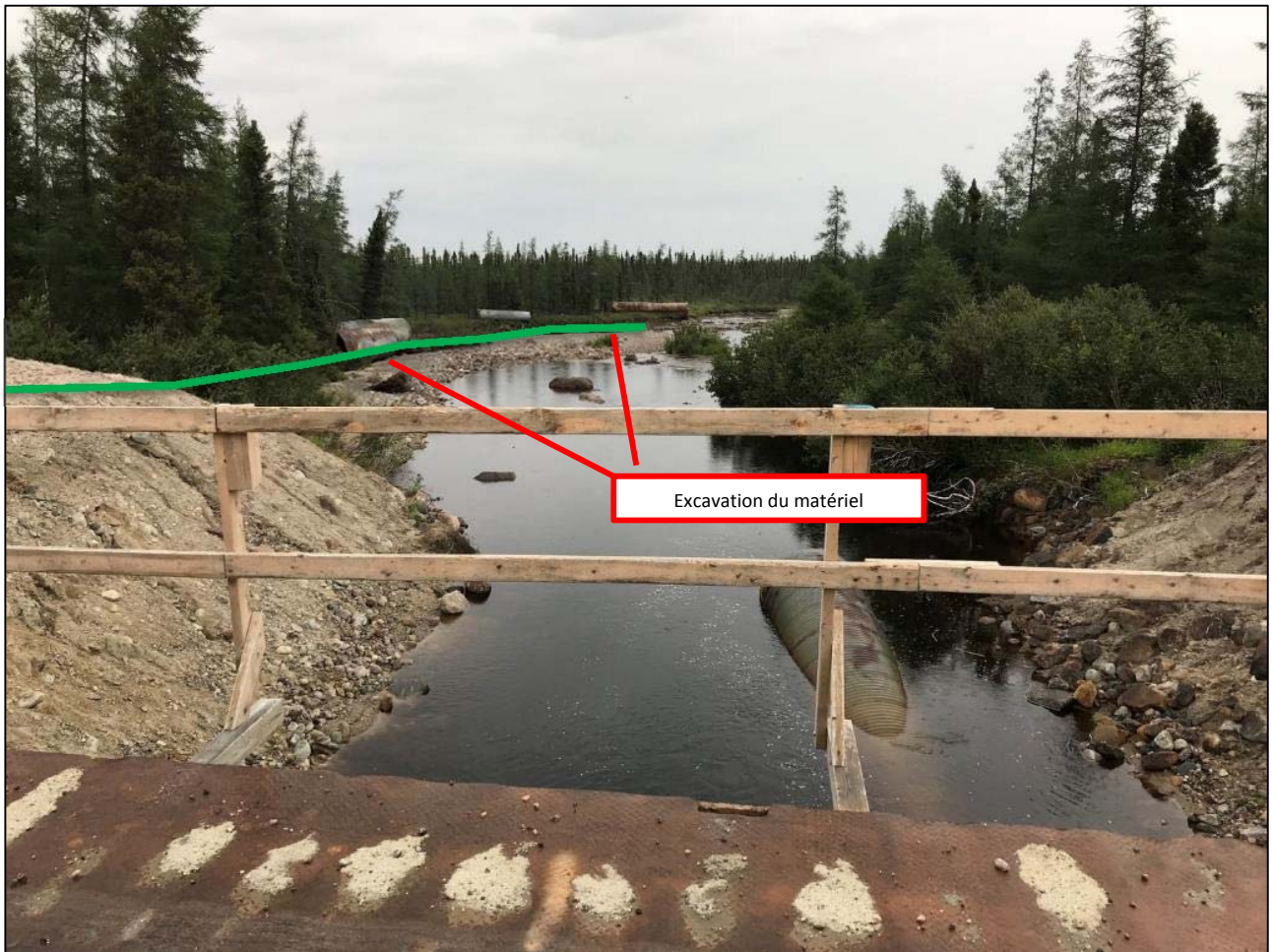
Figure 4. Zone d'excavation du matériel (vue depuis le chemin).
