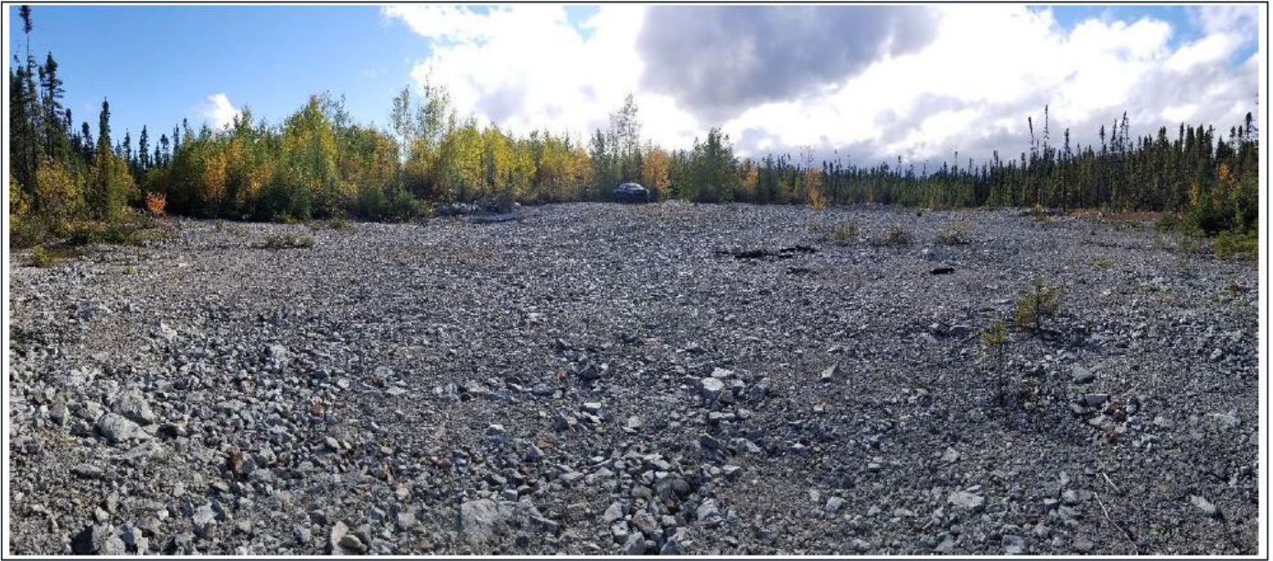
Figure 6 : Site des travaux - Devlin
