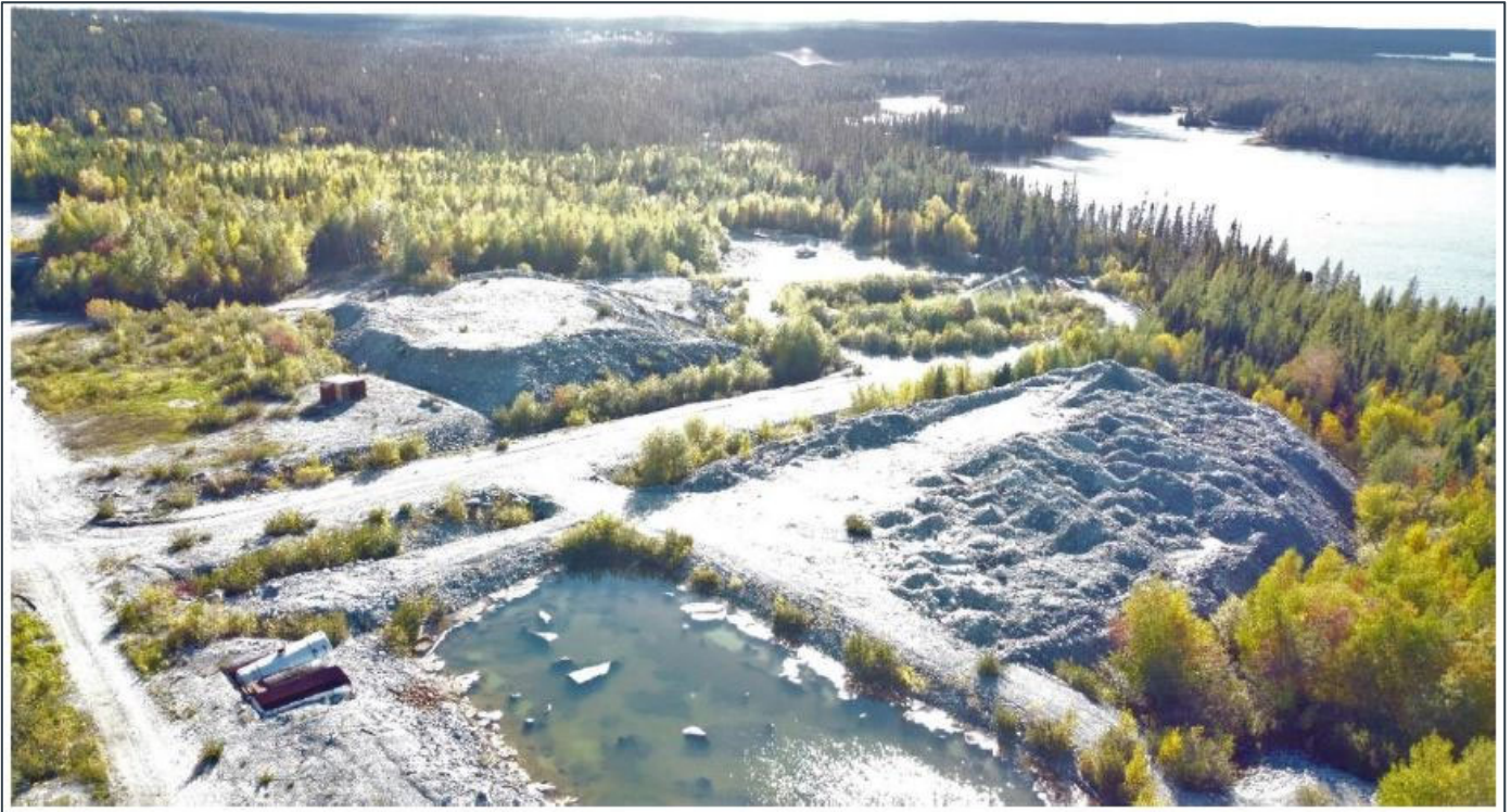
Figure 7 : État actuel du site des travaux - Corner Bay
